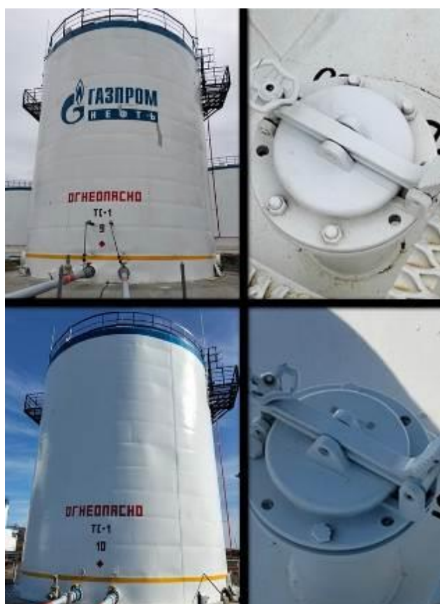
Рисунок 2 – Фотографии общего вида резервуаров стальных вертикальных цилиндрических РВС-1000(№ 9, 10), их горловин замерного люка и заводских номеров
