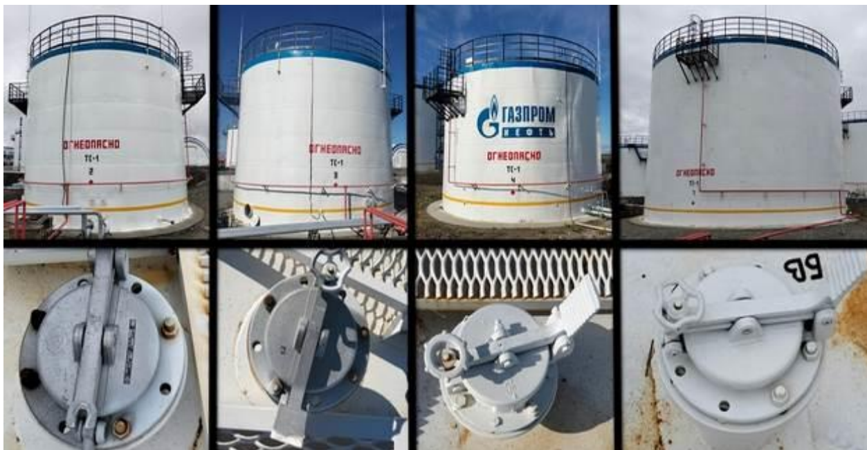
Рисунок 1 – Фотографии общего вида резервуаров стальных вертикальных цилиндрических РВС-1000(№ 2, 3, 4), РВС-3000(№7), их горловин замерного люка и заводских номеров
